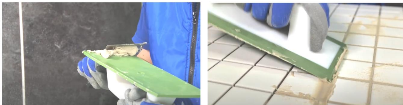
Рис. 22. Заполнение швов затиркой при помощи резинового шпателя
